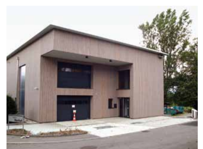
Eingang Werkhof mit Ölsammelstelle
