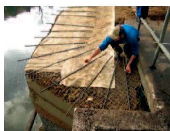
Mit Beton fundiert und mit Sand und Mergel aufgefüllt sowie zum Schutz vor Erosion abgedeckt.
