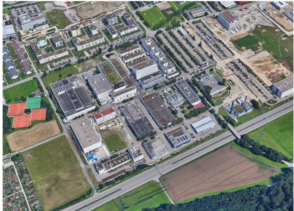
Abb. 21: Das Gelände der Roche aus der Vogelperspektive (Quelle: Google 2018 )
