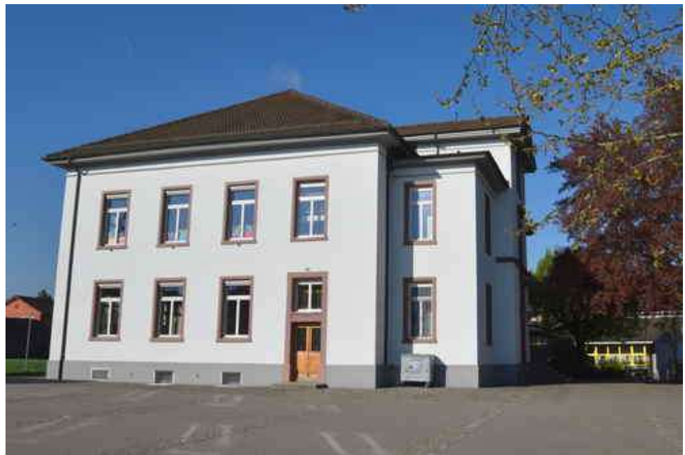
Abb. 23: Das Schulhaus Dorf (Quelle: www.kaiseraugst.ch )
