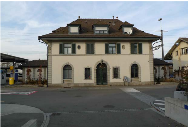
Ansicht von Südosten (2011)
