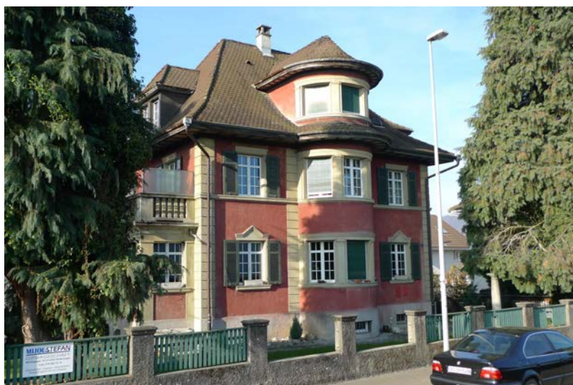
Ansicht von Südosten (2011)
