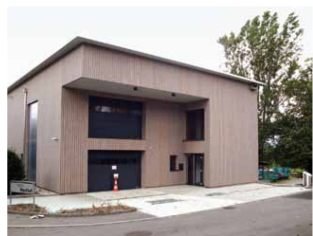
Eingang Werkhof mit Ölsammelstelle
