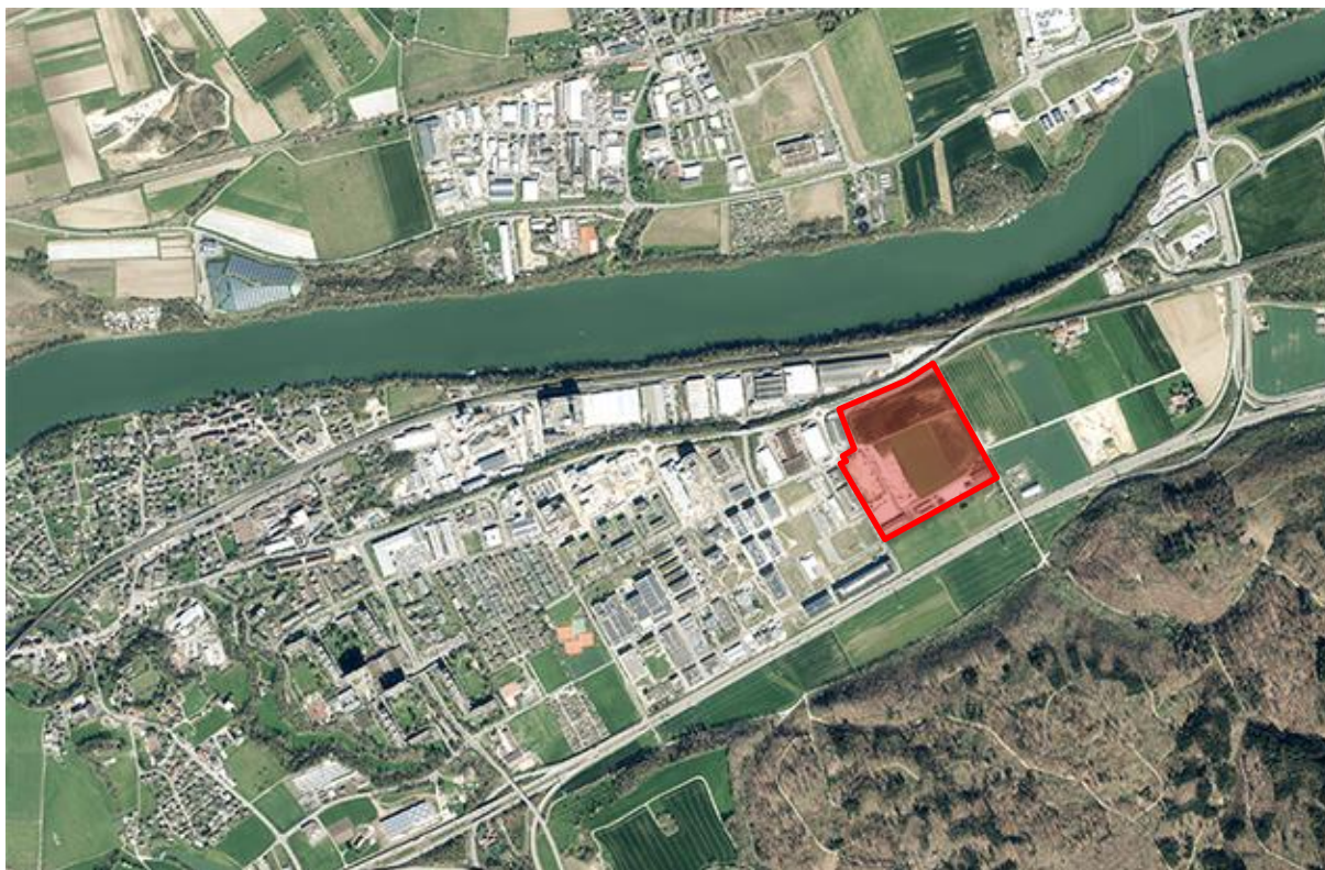
Agis, Kaiseraugst mit dem Areal Aurica (Rot), August 2024
