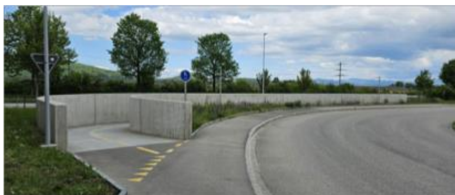
Abbildung 13: Portal Fussgänger- und Velounterführung am Challerenweg
